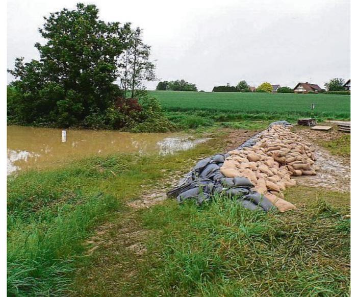
Mit Sandsäcken musste der Damm am Rückhaltebecken erhöht werden.
